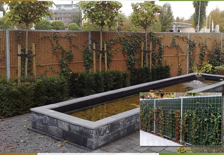
L'écran antibruit Kokowall® LITE est une construction de faible poids offrant une grande isolation sonore. L'extérieur de ces panneaux est recouvert d'un côté de fibres de coco naturelles et durables. Outre leur aspect très naturel les fibres de coco offrent un support idéal aux différentes variétés de plantes grimpantes.
